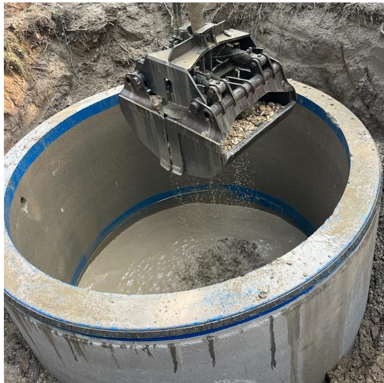
Pozzo autoaffondante scavo a camera bagnata
