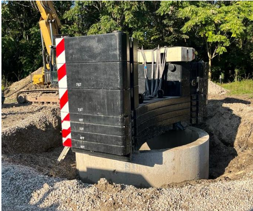
Concio pozzo autoaffondante con zavorre
